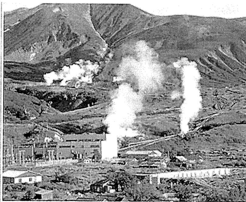
были две турбогенераторные установки с конденсационными турбинами типа МК-2,5 по 2,5 МВт производства «КТЗ» 1964 г.в. и турбогенераторами типа Т2-2,5-2 производства «ЛТГЗ» 1964 года выпуска. Данная станция была экспериментальной, но уже к 1980 году ее установленная мощность составила 11 МВт.
