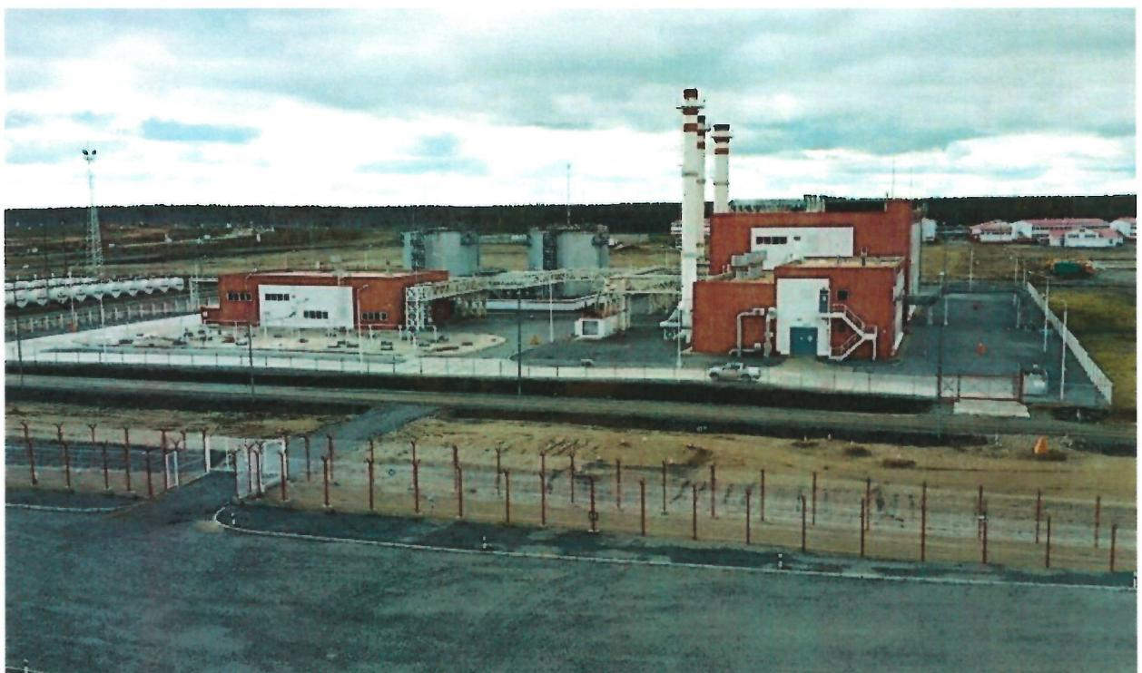
В 2015г. энергоснабжение потребителей ГОКа им. В.Гриба осуществлялось от Энергокомплекса, в состав которого входят 5 дизель-генераторных установок электрической мощностью 5,2 МВт, системы утилизации и рекуперации тепла, пиковая котельная. Общая максимальная электрическая мощность Энергокомплекса – 26,14 МВт и тепловая мощность – 26,4 МВт. Выработка электроэнергии Энергокомплексом указана в таблице №1. Дизельные электрические станции: ДЭС-1968, ДЭС-200 находились в резерве.
